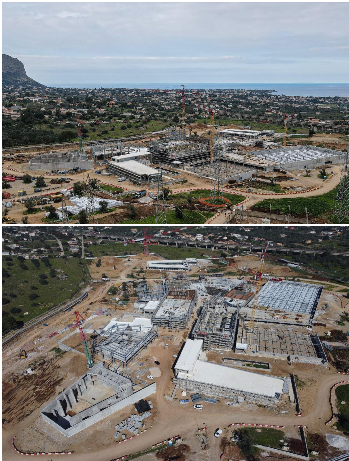
Figure 5-8: Cantiere del Centro di ricerca della Fondazione Ri.MED
